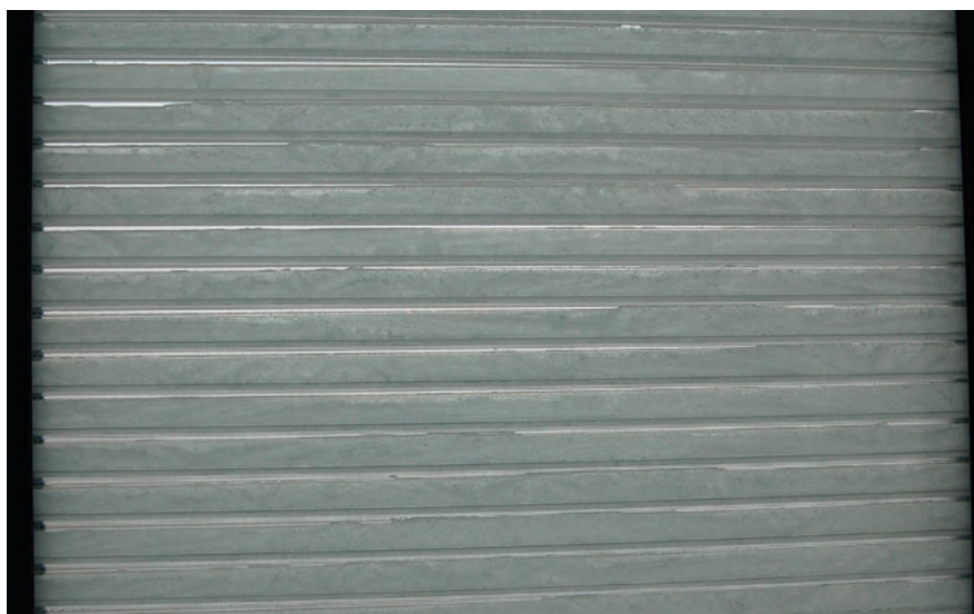
Figure 3 Panneau PCM (Phase Changing Material) disposé derrière le vitrage isolant pour atténuer les élévations de température dans la salle.
