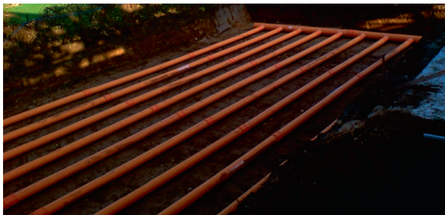
Figure 2 Exemple de puits canadien sous une maison familiale.
